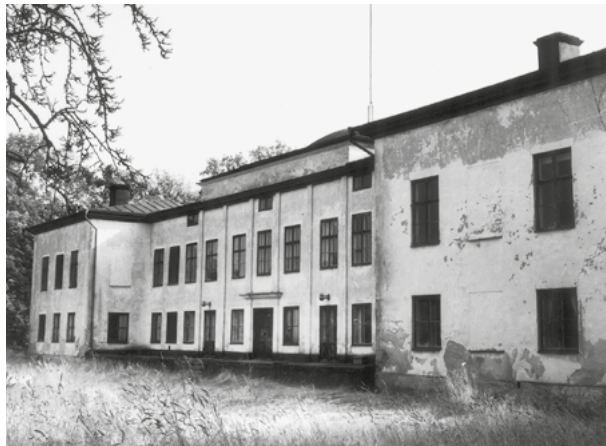
Gränsö slott i förfall - innan Klarkullen påbörjade upprustningen 1992.
